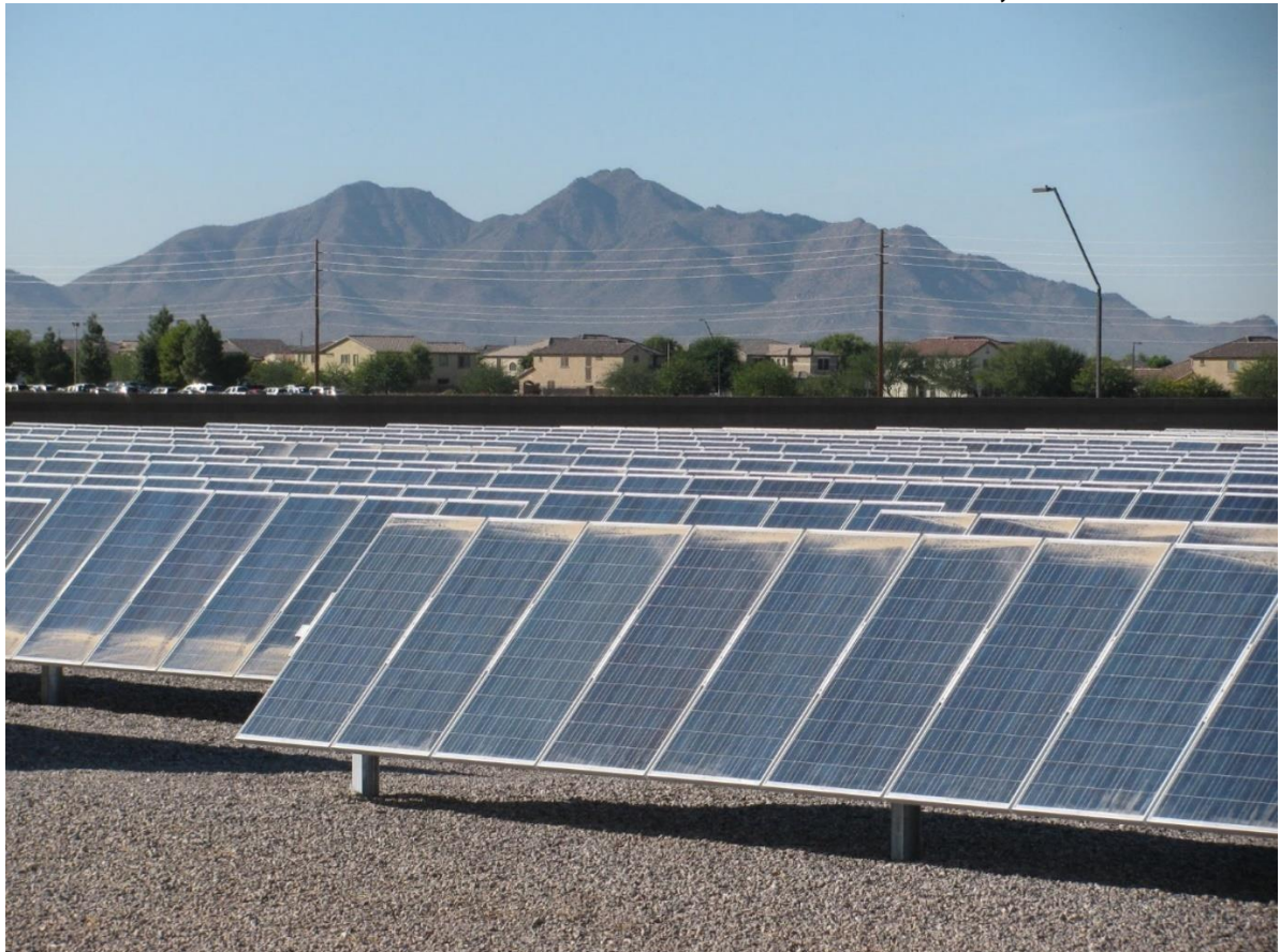
Figura 21. Diferentes padrões de deposição de sujeira sobre os módulos fotovoltaicos instalados na Usina Solar de Queen Creek, no Arizona
