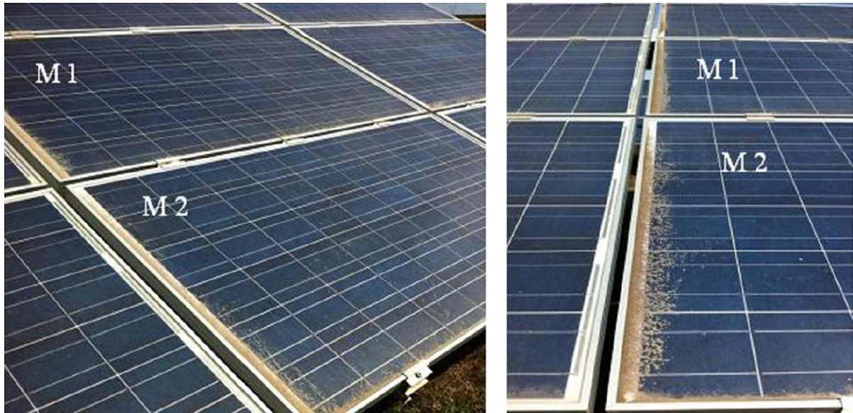
Figura 22. Padrão de deposição não uniforme de sujidade em uma instalação de 2 MW em Cartagena, Espanha
